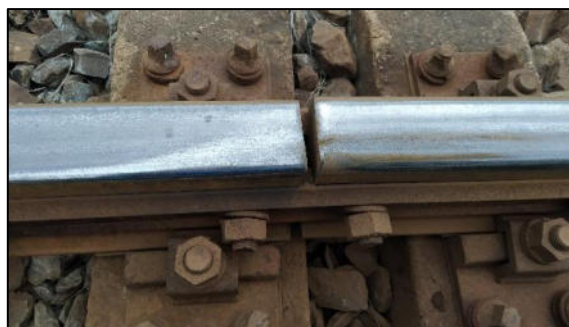
Obr. 7 – Pohled na styk kolejnic před řešeným objektem
