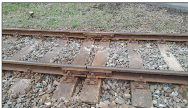
Obr. 9 – Pohled na styk kolejnic před měřicím místem MB 2
